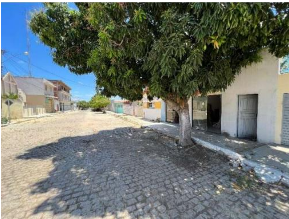
Imagem 3: Vista da fachada.
