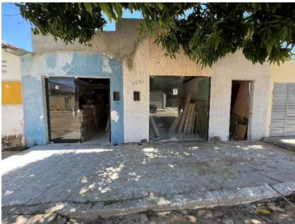
Imagem 1: Vista da fachada.
