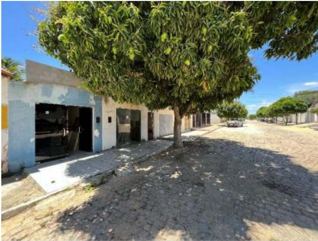
Imagem 2: Vista da fachada.
