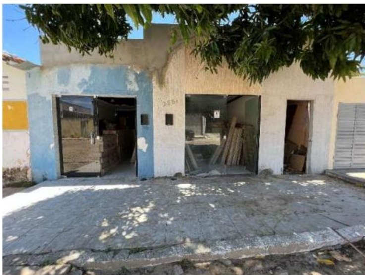
Imagem 1: Vista da fachada.
